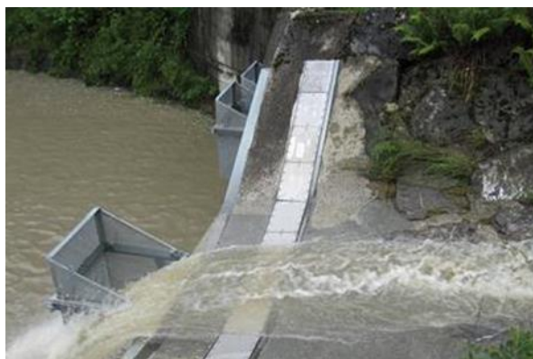
Figure 4: Trappe installée sur un seuil sur l'Erlenbach (WSL)
